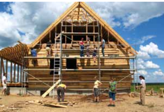
Bau von Lehmhäusern für Umsiedler - Heimstatt- Tschernobyl
